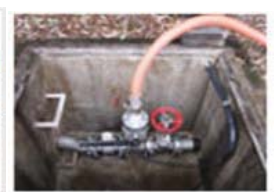
管路へ注入・圧送
