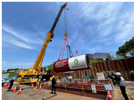
水道管更新工事(シールド工事)
