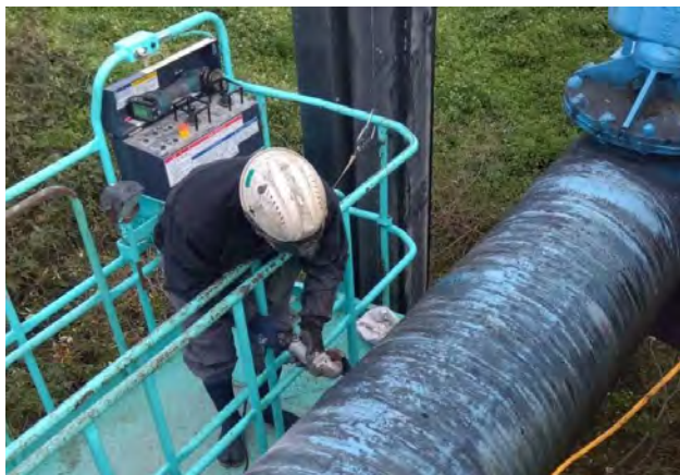
水管橋調査の様子
