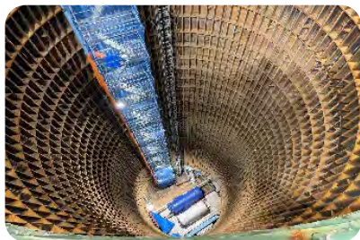
羽沢町立坑(深さ約48m)
