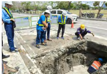
漏水修理の現場指導(フィリピン)
