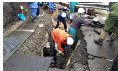
被災地での応急復旧
