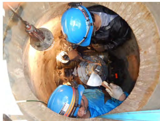
仕切弁調査の様子
