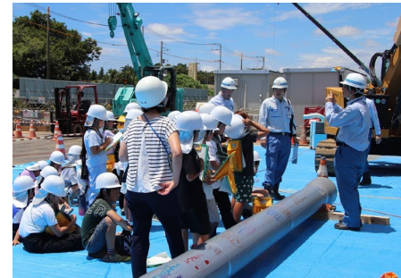
小学生向け工事見学会
