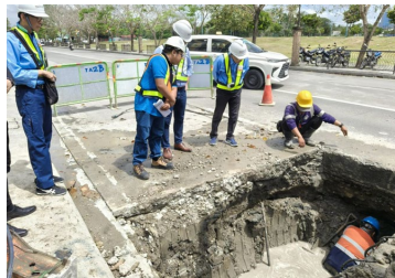
漏水修理の現場指導(フィリピン)
