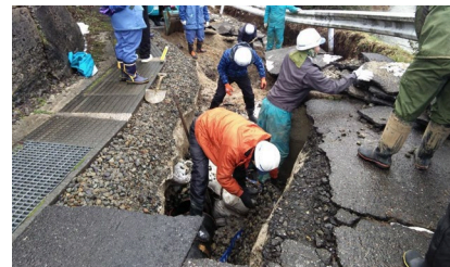
被災地での応急復旧
