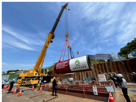
水道管更新工事(シールド工事)
