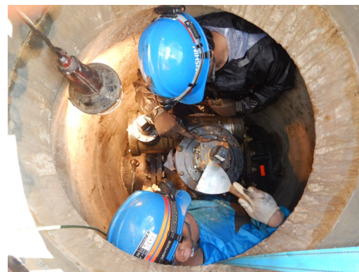
仕切弁調査の様子
