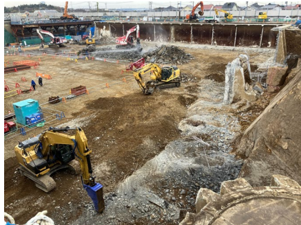
西谷浄水場再整備(1号配水池)
