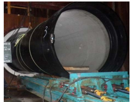
大口径管路更新工事
