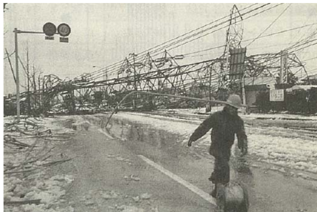
大雪による送電鉄塔の倒壊 (昭和 61 年)
