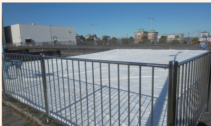
建築用養生シート設置後の様子
