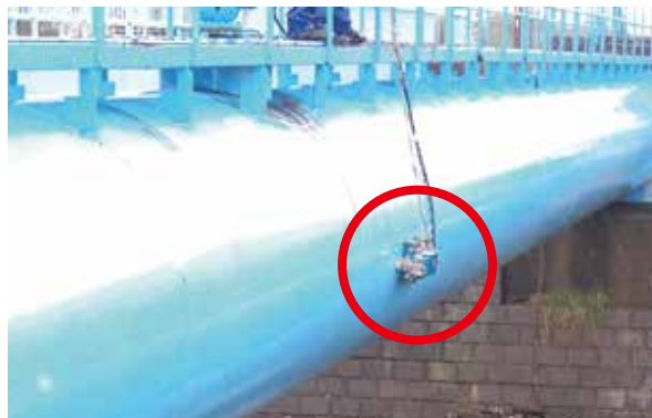
ロボットによる水管橋の点検
