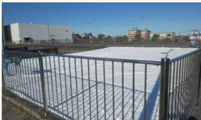
建築用養生シート設置後の様子
