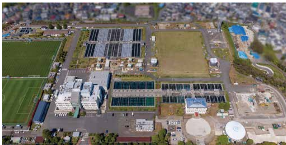
西谷浄水場(再整備事業前)
