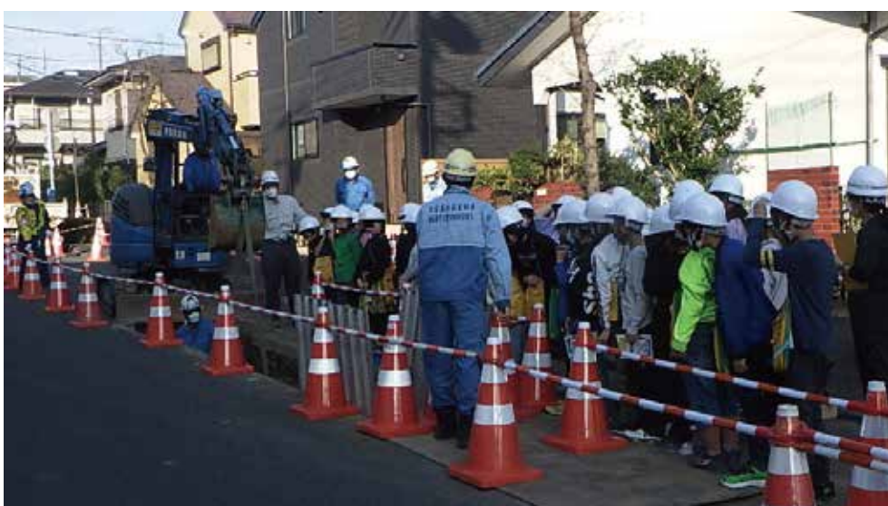
工事現場見学会の様子
