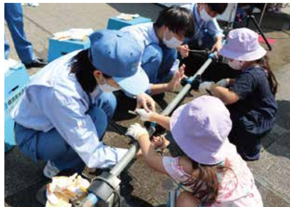
イベントでの漏水修理体験
