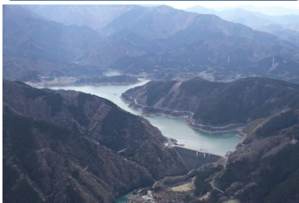
宮ヶ瀬ダム (平成 13 年完成)
