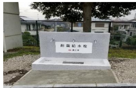
青葉区鴨志田緑小学校の耐震給水栓
