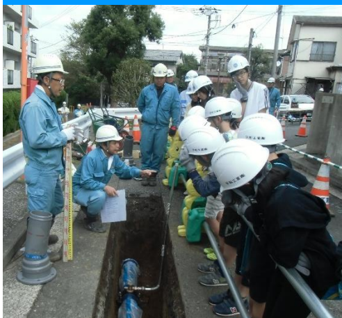
工事現場見学会
