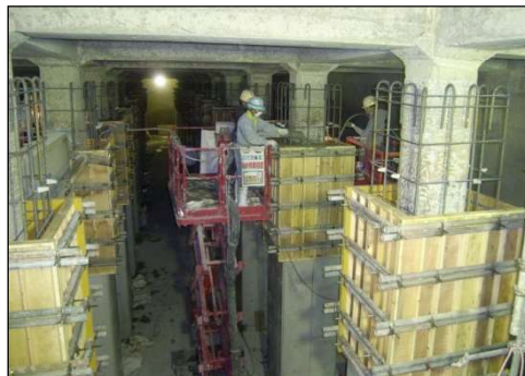
配水池の耐震補強工事
