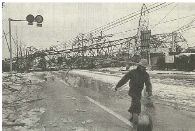
大雪による送電線の鉄塔の倒壊（昭和 61 年）
