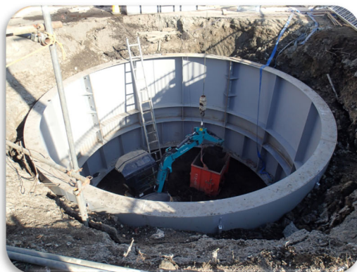
《防火水槽新設工事》
