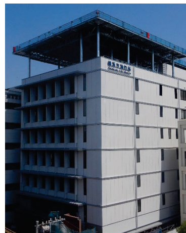
< 消防本部庁舎 >
