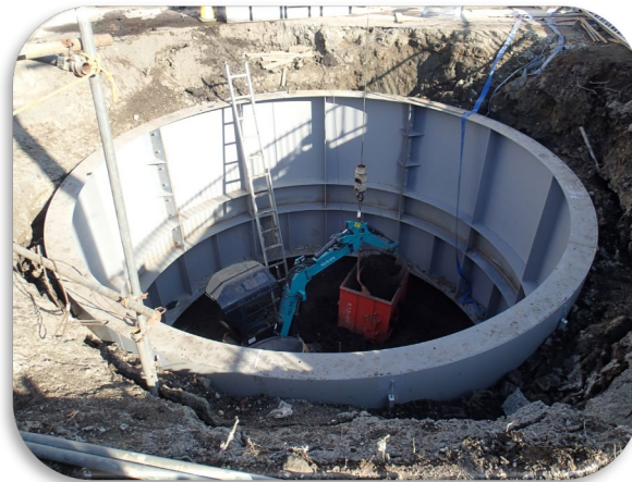
《防火水槽新設工事》
