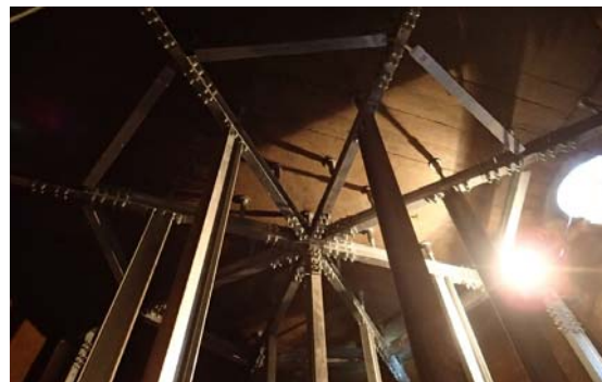
防火水槽補強工事
