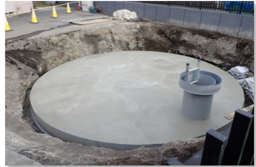
<防火水槽新設工事>
