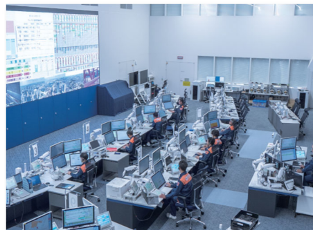
<消防司令センター>
