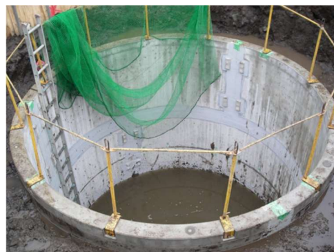
<防火水槽新設工事>
