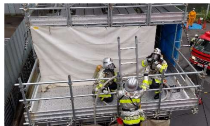
<仮設訓練施設>
