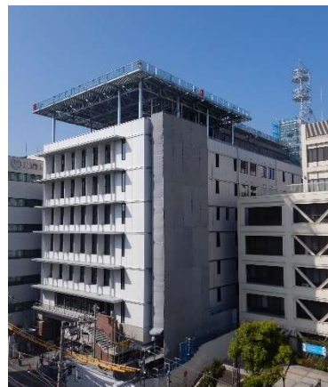
< 消防本部庁舎 >
