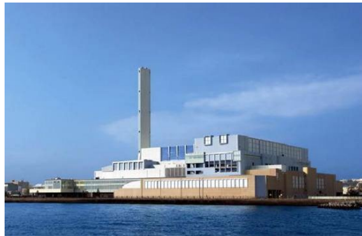
長寿命化工事中の 「JFE横浜金沢マリンエネルギーセンター(金沢工場)」
