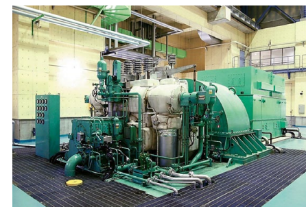
改修を予定する蒸気タービン
