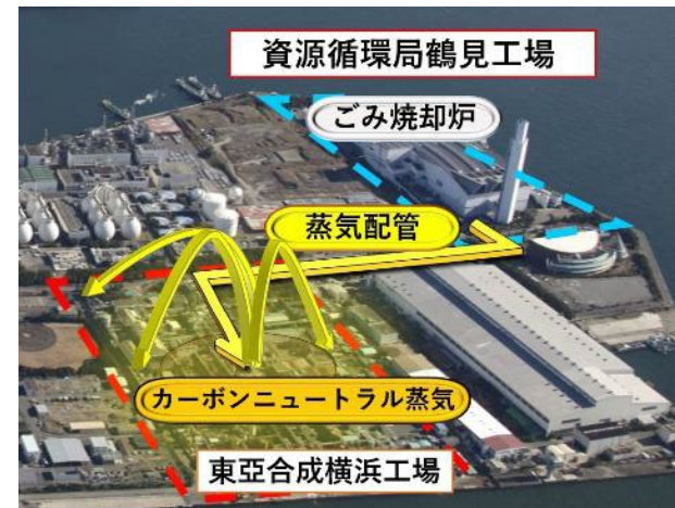
鶴見工場周辺地域の熱供給の全体図
