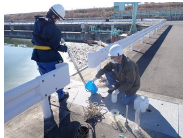
南本牧第5ブロック廃棄物最終処分場 での採水作業の様子
