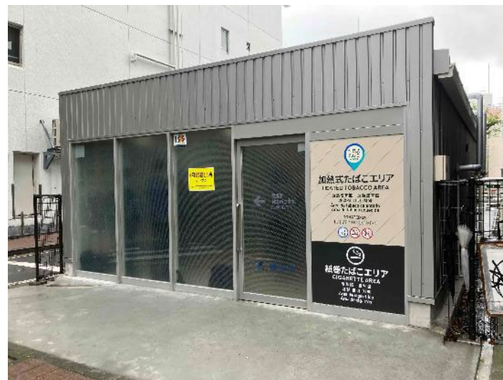
密閉型喫煙所として整備した横浜駅西口北幸喫煙所
