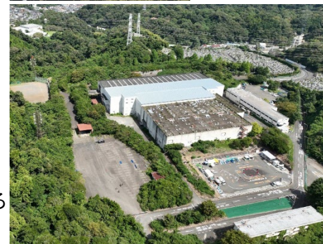
跡地活用の 検討を進める 旧栄工場
