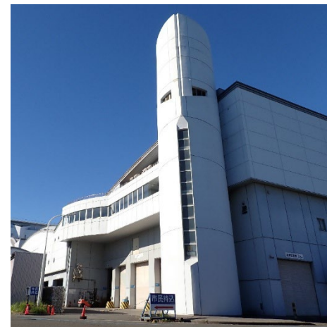
再整備予定の鶴見資源化センター
