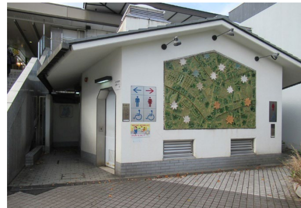
改修を予定している十日市場駅前公衆トイレ
