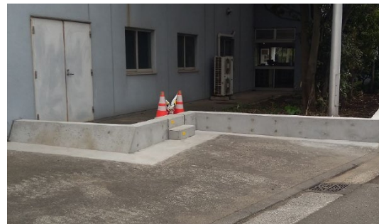
浸水対策(止水壁設置)事例
