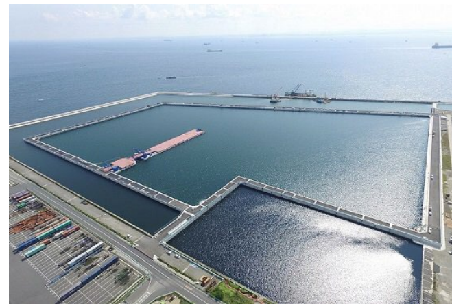
南本牧第5ブロック廃棄物最終処分場
