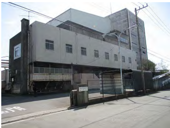
現況写真①
