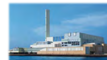
工場の新設・長寿命化工事
