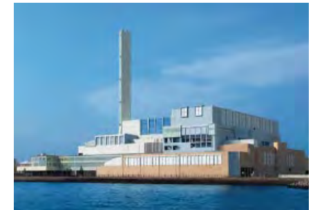
焼却工場の再整備や長寿命化工事
