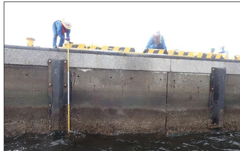
【港湾施設等の点検 岸壁防舷材調査】
