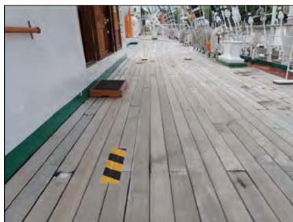
【甲板の一部張替え】
