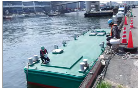
【港湾施設等の修繕 浮棧橋補修】
