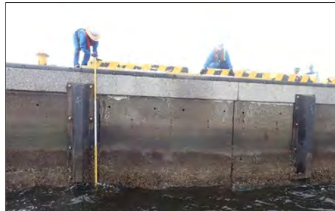
【港湾施設等の点検 岸壁防舷材調査】
