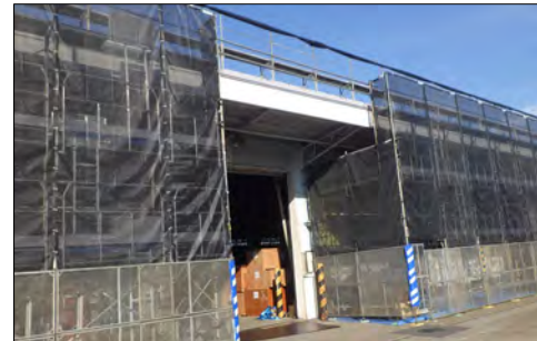
【上屋の修繕 屋根防水及びシャッター修繕】
