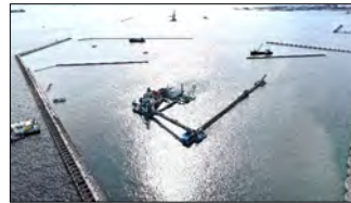
【新本牧ふ頭でのリクレーマー船による土砂投入状況】
