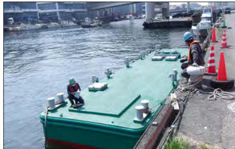
【港湾施設等の修繕 浮棧橋補修】
