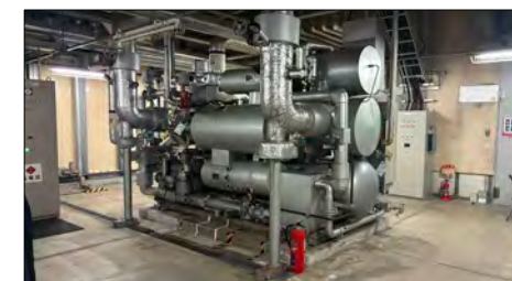
【20年以上が経過した空調設備】
