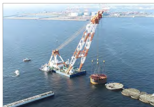
【鋼板セルの設置状況】
