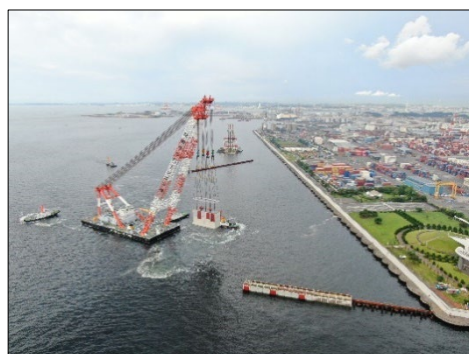
【ケーソン据付状況】
