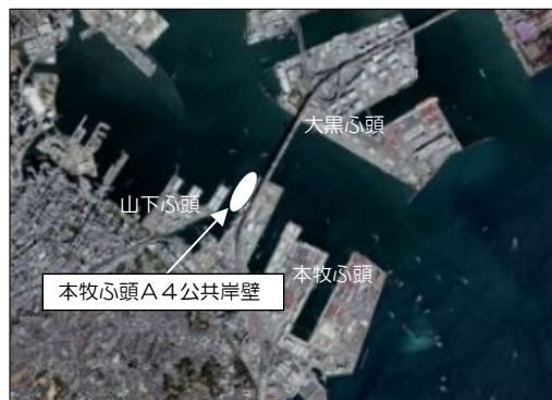
【陸上電力供給設備の整備箇所】
