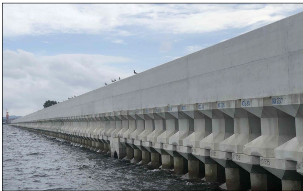
【金沢区福浦地区護岸復旧状況】
