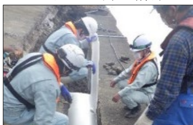
【護岸復旧工事（空洞補修）】
