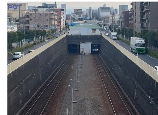
新羽駅～北新横浜駅間
