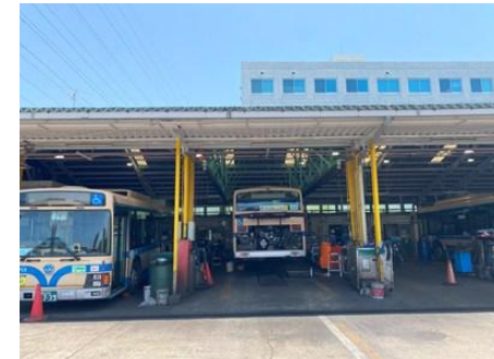
港北営業所車両整備工場
