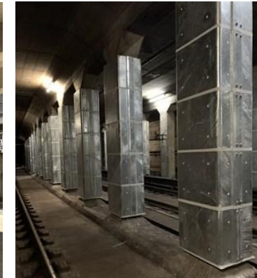
開削トンネル部
