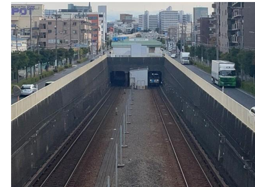
新羽駅～北新横浜駅間
