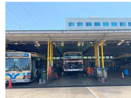
港北営業所車両整備工場
