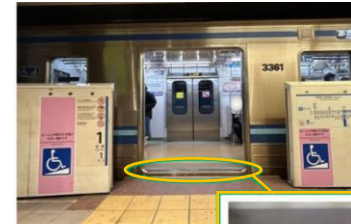
ホームと車両の隙間 (縮小後)
