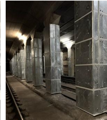
開削トンネル部
