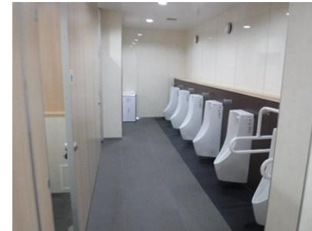
センター南駅トイレ（6年度施工）
