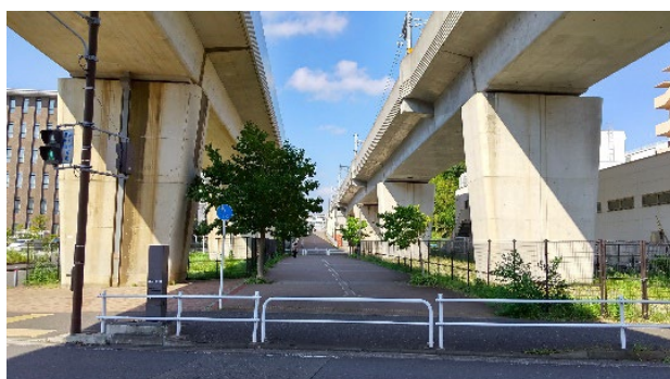
<センター南北駅間高架下>
