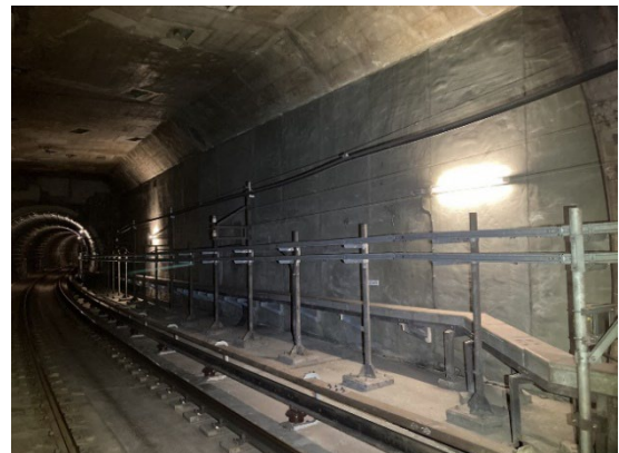
<開削トンネルの補修>
