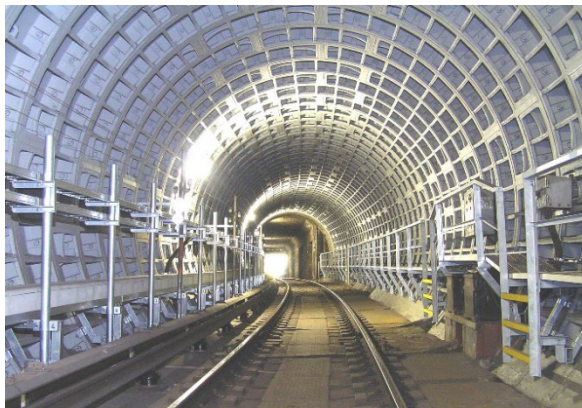
<シールドトンネルの補修>
