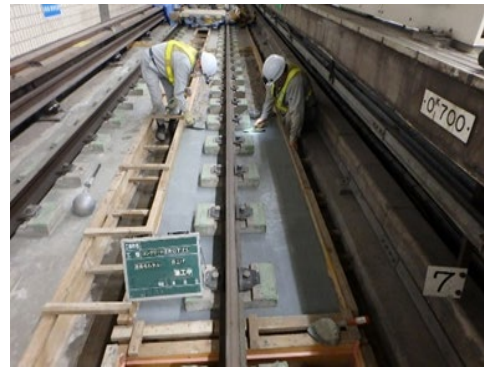
<軌道改良工事>
