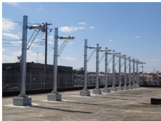
<留置線引留柱工事>
