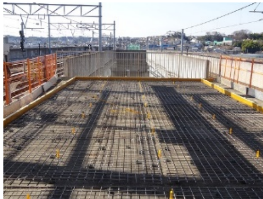
<駅ホーム工事>
