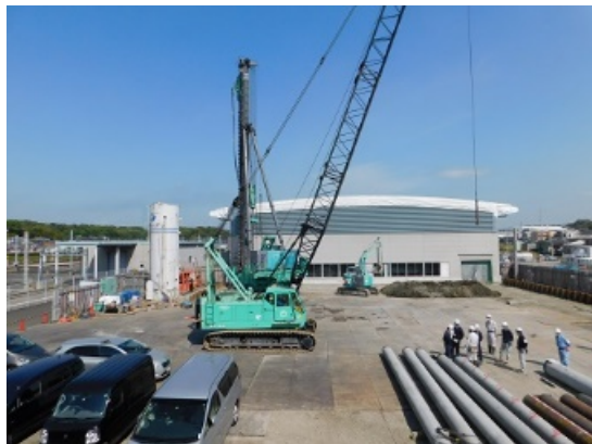
<検修庫増築工事>
