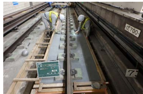
<軌道改良工事>
