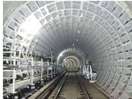
<シーールドトンネルの補修>
