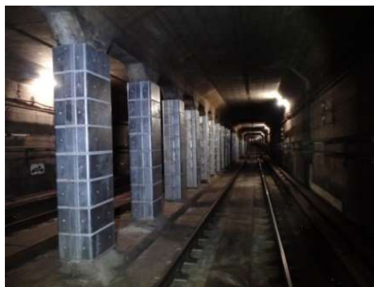
＜開削トンネル中柱の補強＞
