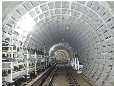
&lt;シールドトンネルの補修&gt;
