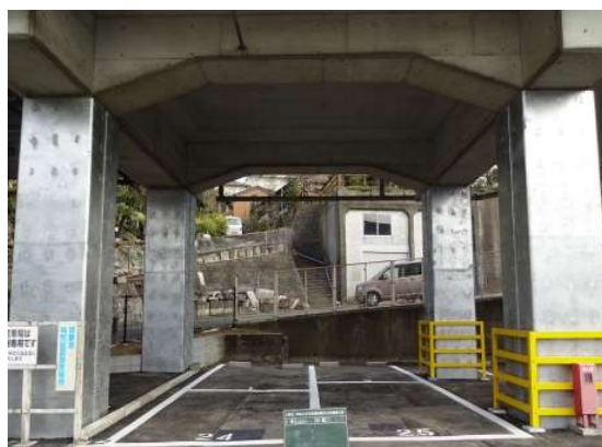
＜ラーメン高架橋の橋脚の補強＞
