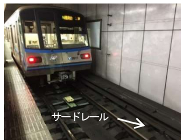
＜サードレールの敷設写真＞
