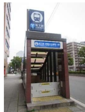
＜止水板設置状況＞ (伊勢佐木長者町駅)
