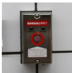
緊急停止装置(既設)
