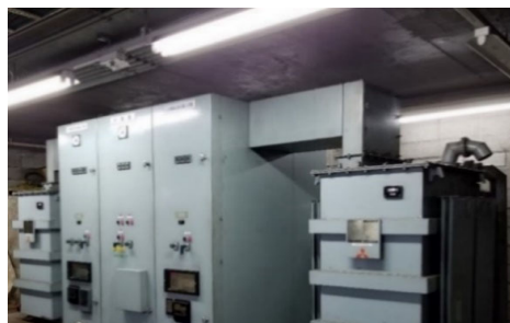
弘明寺駅電気室のPCB含有変圧器
