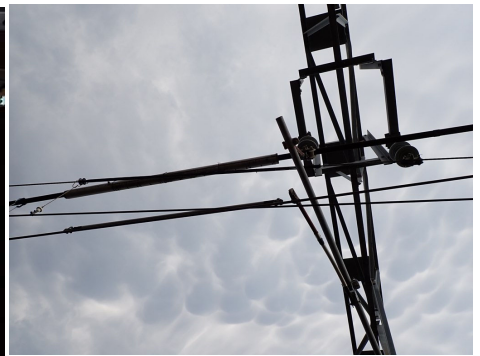
吊架線支持物と横引き金具
