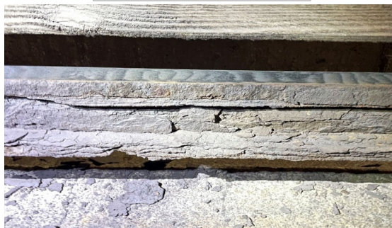
腐食したサードレール
