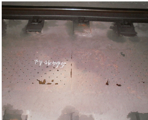
排水溝蓋(アンチスリップ鋼板)
