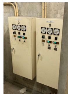
湧水ポンプ盤・汚水ポンプ盤
