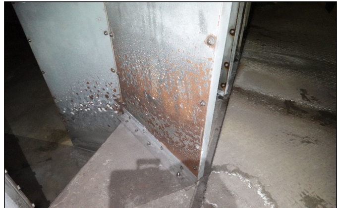
▲沢渡換気塔の整風板腐食状況
