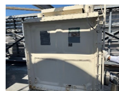
屋上消火栓補助水槽
