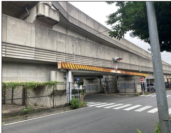
▲北新横浜～新羽 高さ制限ゲート
