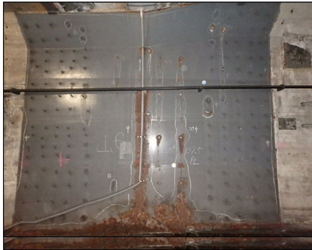
▲関内・長者町ケーソン耐震鋼板 上り
