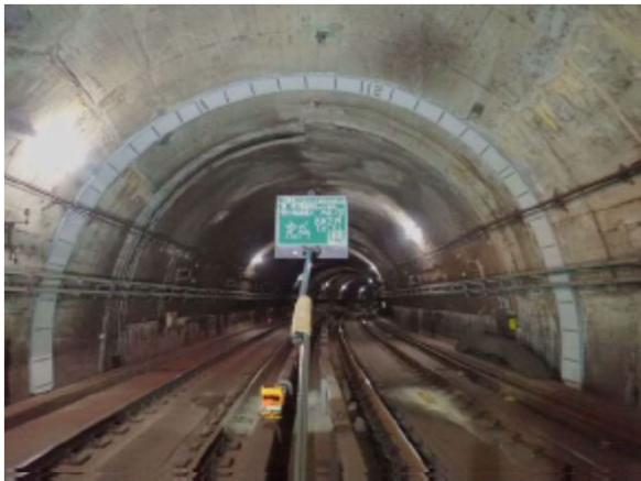
受け樋設置工
