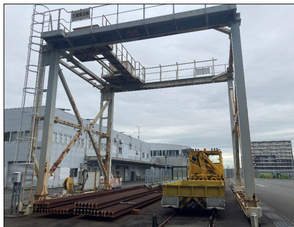
▲川和車両基地 門型クレーン
