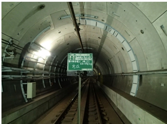
受け樋設置工
