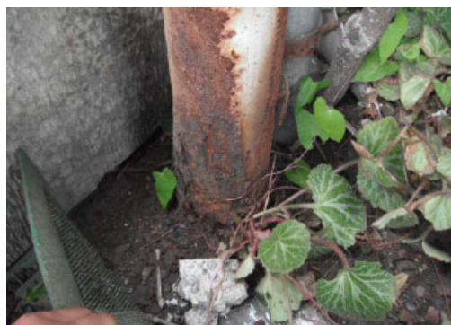
【上屋の支柱部分】
