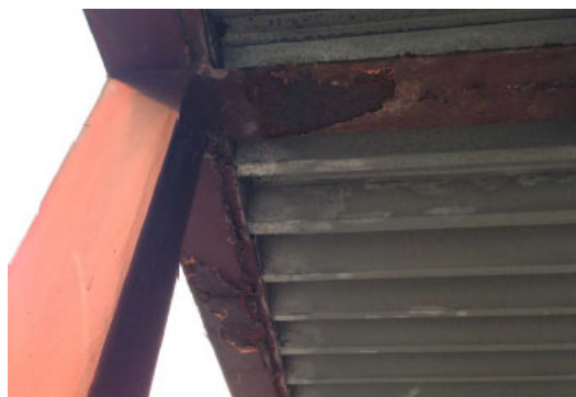
【上屋の梁部分】
