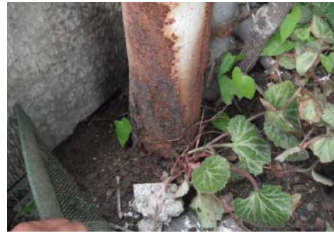
【上屋の支柱部分】
