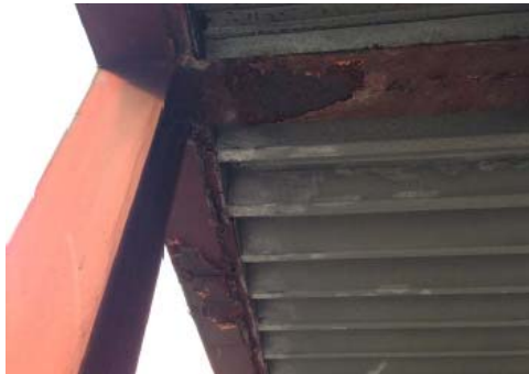
【上屋の梁部分】
