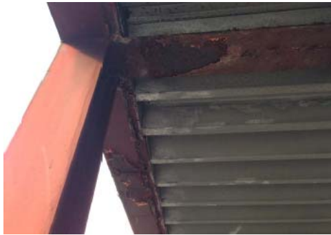
【上屋の梁部分】
