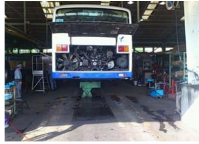
港北営業所の既存リフト
