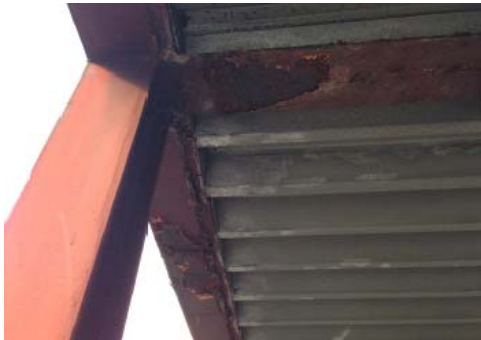
【上屋の梁部分】
