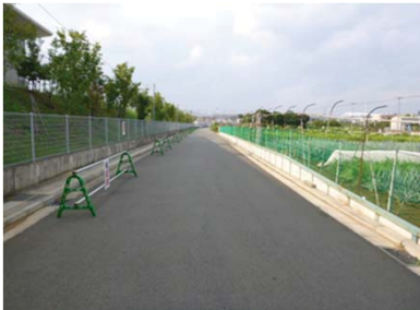
▲周辺道路状況②
