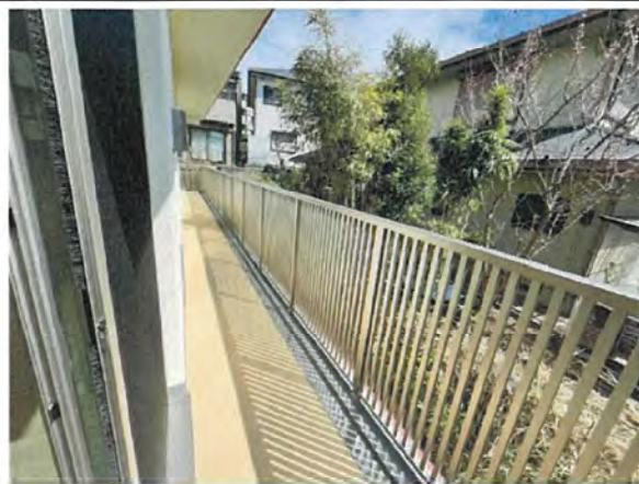
2 1 . パ ル コ ニ ー 通 路 ( 避 難 路 )
