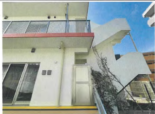
11. 避難階段出口
