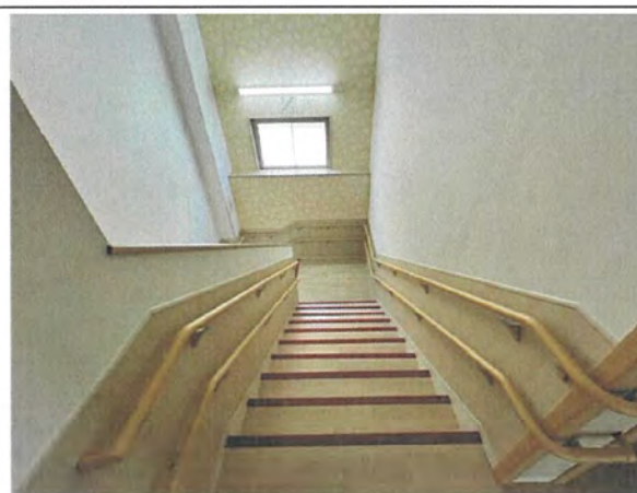
2 3 . 屋 内 階 段 ( 避 難 路 )
