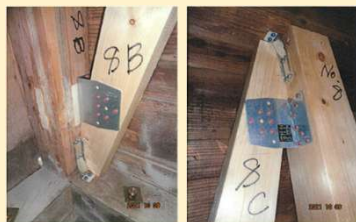
耐震改修工事金物施工状況
