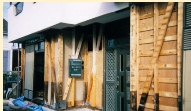
木造住宅の耐震工事施工状況
