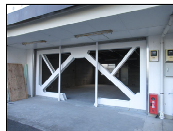
マンションの1階ピロティ部分に耐震ブレースを新設した事例
