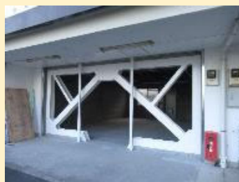
ピロティ部分に耐震ブレースを新設した事例
