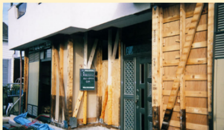
木造住宅の耐震工事施工状況
