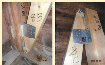
耐震改修工事金物施工状況
