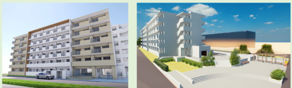
さかえ住宅・洋光台住宅(A街区)完成イメージ
