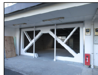
マンションの1階ピロティ部分に耐震ブレースを新設した事例
