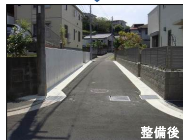
狭あい道路拡幅整備工事
