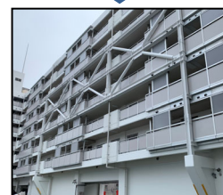
耐震改修補助金利用例
