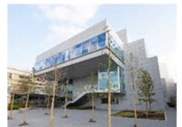
港南公会堂外観
