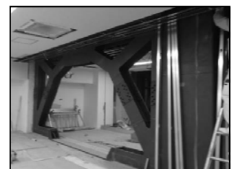
耐震改修事例（ブレース設置工事） ㈱ケー・アール建築研究所 提供
