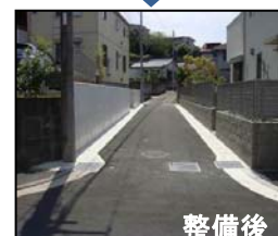
狭あい道路拡幅整備工事
